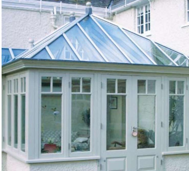
*Alle Dach - und Schrägverglasungen sind noch stärker von der Beschlagbildung an der äußeren Scheibe betroffen.*
